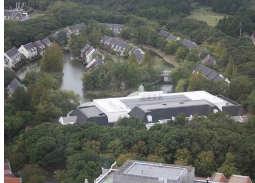
< 하우스텐보스 내 태양광 패널 >
